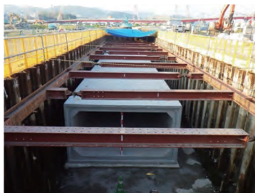
雨水渠布設工事
