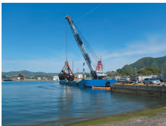
漁港整備（浚渫*）
