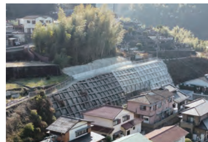
急傾斜地崩壊対策事業
