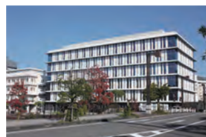
誘致企業が入居するオフィスビル「クレインハーバー長崎ビル」
