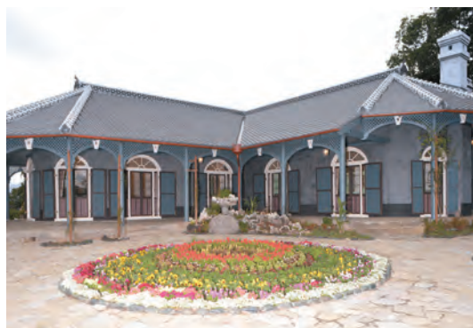
保存修理後の国指定重要文化財旧グラバー住宅
