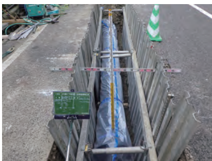
配水管布設工事
