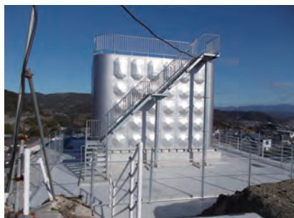
耐震化された配水槽
