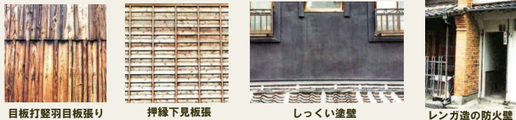
目板打堅羽目板張り 押縁下見板張 しっくい塗壁 レンガ造の防火壁
