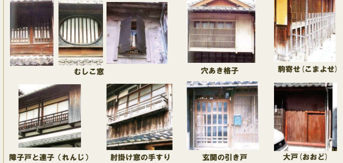
障子戸と連子(れんじ) 肘掛け窓の手すり 穴あき格子 駒寄せ(こまよせ) 大戸(おおど)
