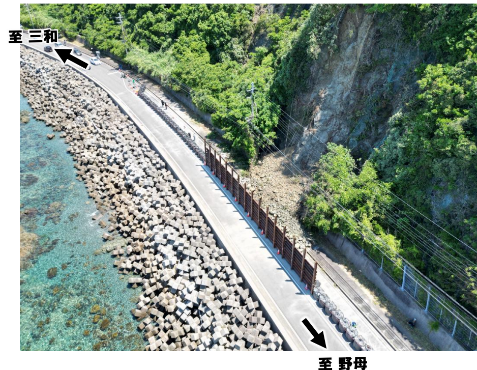
仮設状況 5月18日時点
