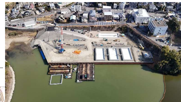
仮設ヤード工 (R8. 1時点)
