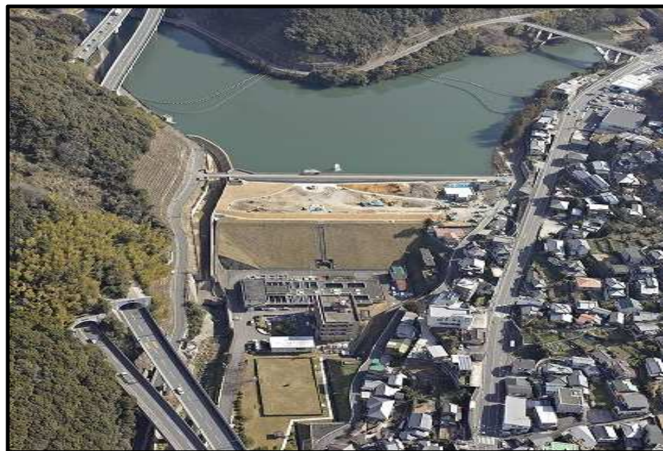
※本河内高部ダム 明治24年築造
