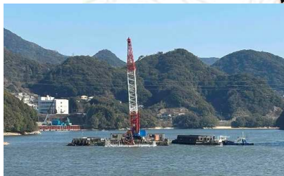
貯水池掘削 (R8. 2時点)
