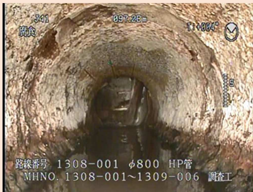
管更生 施工前
