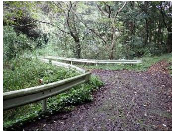
黒浜ダム最奥部の道路
