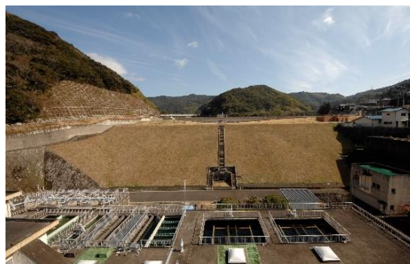
本河内高部水道施設（堰堤）
