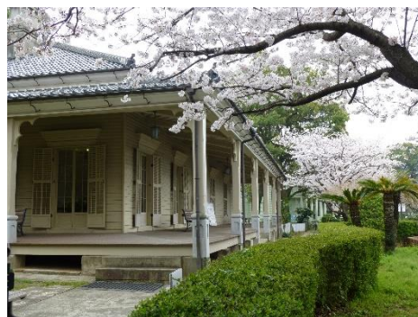
東山手地区内の木造洋風建築
