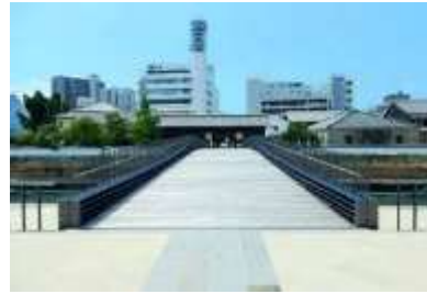
—出島表門橋（江戸町側から）—
