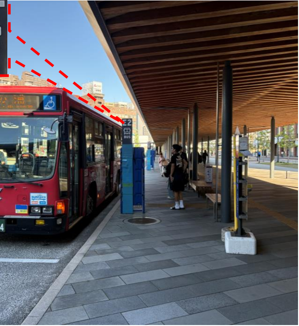
誘導サインの設置状況 (各バス停に標柱を設置)
