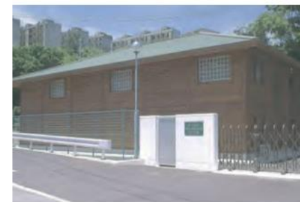
南風泊漁業集落排水処理施設
