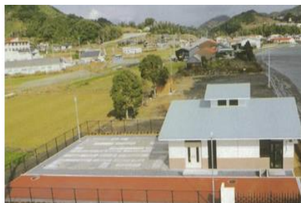
大江・形上農業集落排水処理施設
