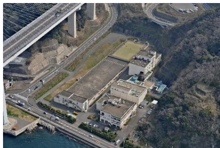
南下水処理場
