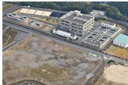
東長崎浄水場
