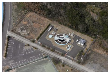
高島浄化センター
