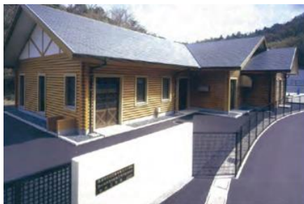
高浜農業集落排水処理施設
