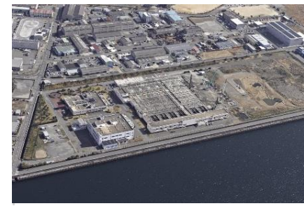
西下水処理場
