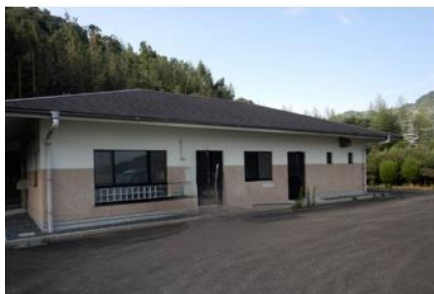
太田尾農業集落排水処理施設
