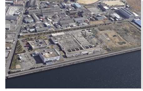
西下水処理場
