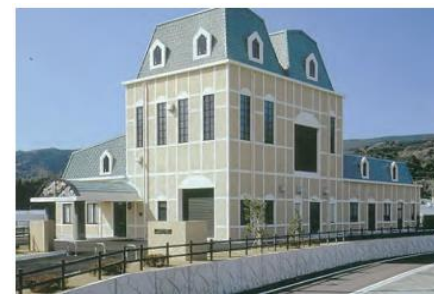
琴海中部農業集落排水処理施設
