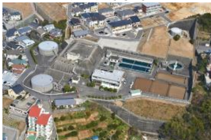
道ノ尾浄水場
