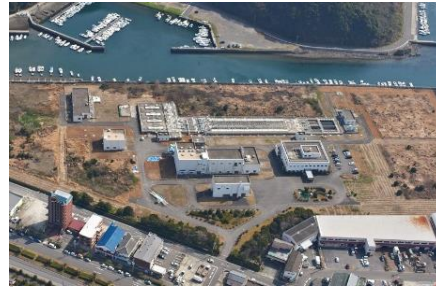
三重下水処理場
