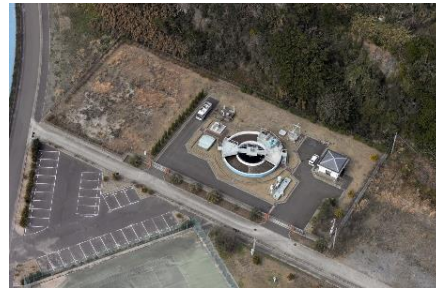
高島浄化センター
