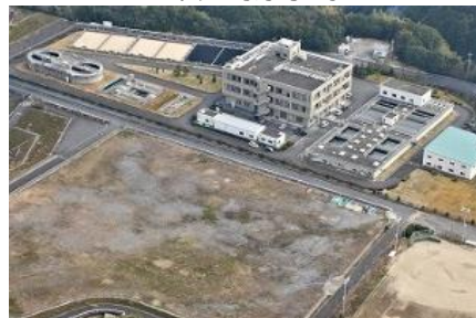
東長崎浄水場
