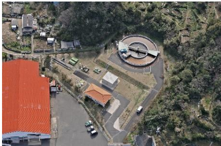
伊王島浄化センター
